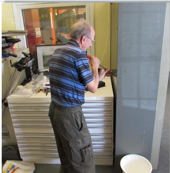
Lars Frennemo filar upp ett hål för en kabel till hörselslingan.
