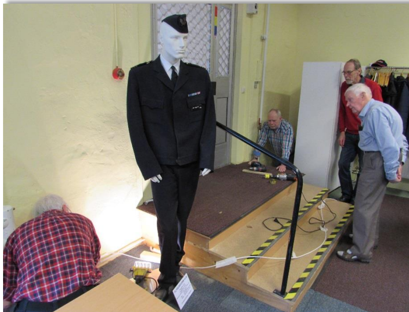
Göran går bakom ryggen på militären och drar kabel för hörselslingan.
